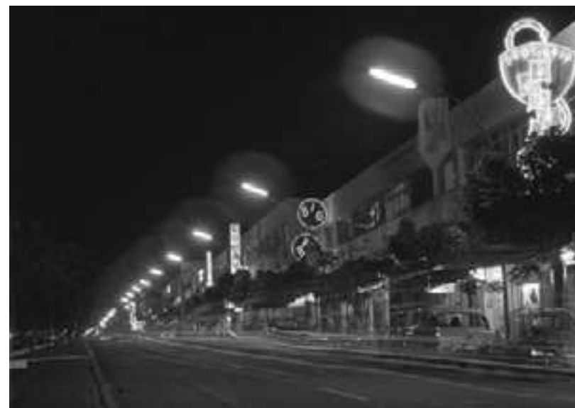
Avenida W3 Sul nos anos 60. Crédito: Arquivo Público do Distrito Federal.
